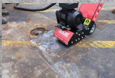
Retirada de recubrimientos y corrosión
